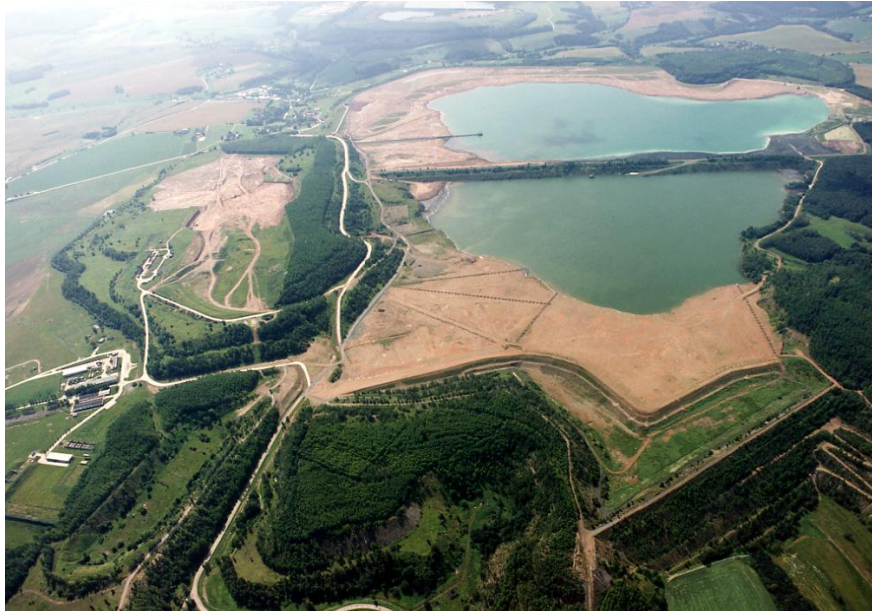
Abb. 5: IAA Culmitzsch und die Lokhalde (links im Bild) in einer Luftaufnahme aus dem Jahr 1992
