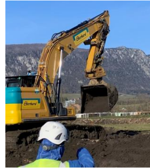
Abb.2: Bagger mit Radioaktivitätsdetektor
