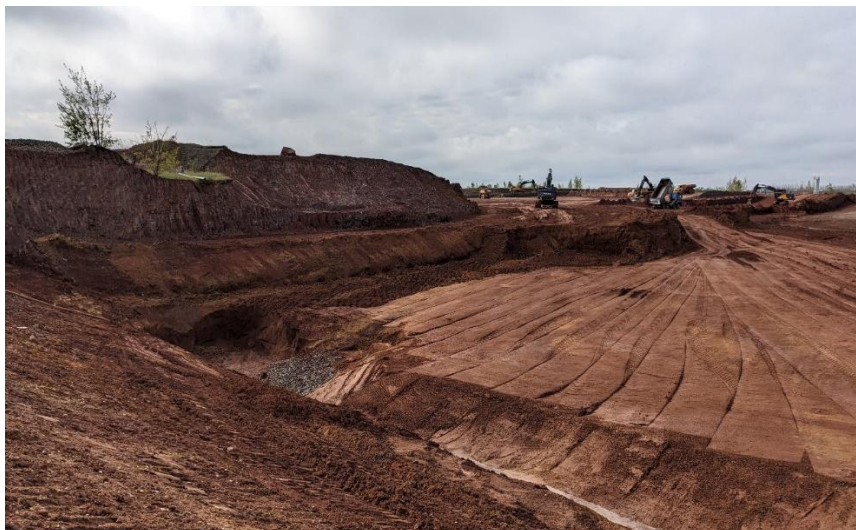
Abb. 6: Abtragsarbeiten auf der Lokhalde im April 2024
