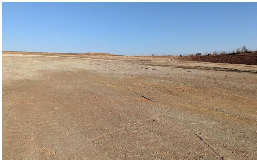
Abb. 7: Freigelegte Haldenaufstandsfläche, anstehend Tonschieferzersatz, die quartären Deckschichten fehlen
