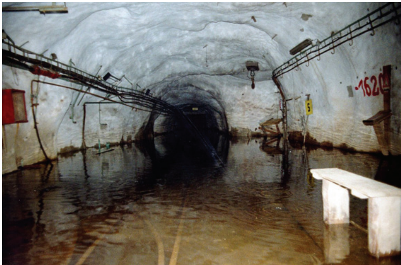
Abb. 6: Flutungswasserstand Sohle -1620 m Schacht 371 Schlema-Alberoda, Januar 1995
