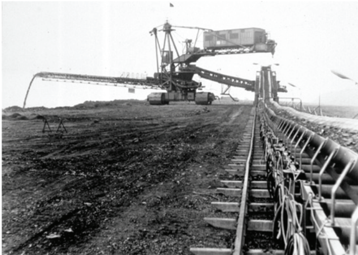
Abb. 2: Tagebau Lichtenberg mit Bandanlage und Absetzer 1970
