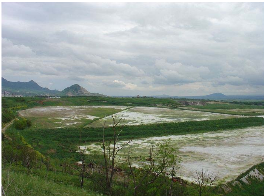
Abb. 3: Abdeckung der Absetzanlage nahe dem GMZ Lermontov mit Phosphorgips
