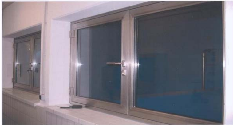
Abb. 6: Radondichte Abtrennung der Wasserkammern vom Vorraum eines Hochbehälters
