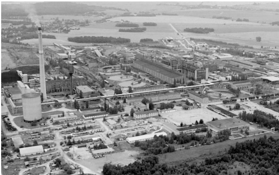
Abb. 1: Ehemalige Uranerzaufbereitungsfabrik Seelingstädt in Thüringen (Aufnahme der mittlerweile rückgebauten Anlage aus dem Jahr 1991)
