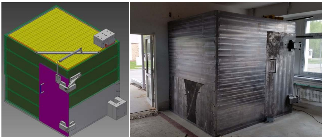
Abb. 4-1: VKTA-Abschirmkammer: Konstruktionszeichnung und im Aufbau
