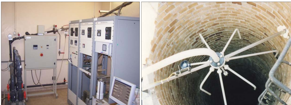
Abb. 3: Messtechnik und Probenentnahmerechen ab 1993
