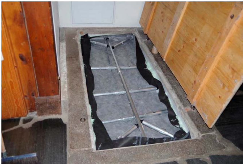
Abb. 4: Versuchsweise Abdichtung einer Falltür zu einem Gewölbekeller mit Radonaktivitätskonzentrationen von 88.800 \text{ Bq/m}^3 in einem Wohnhaus mit dem Express-Wetterblenden-System
