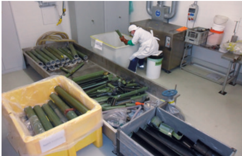
Abb. 3: Dekontamination von Aktivabwasserleitungen
