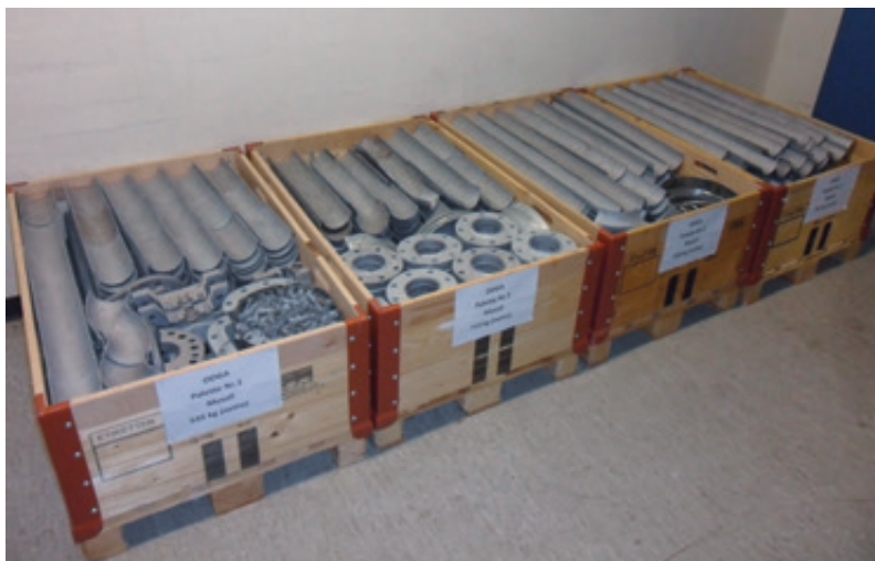
Abb. 4: Die im Jahr 2019 freigegebenen Aktivabwasserleitungen
