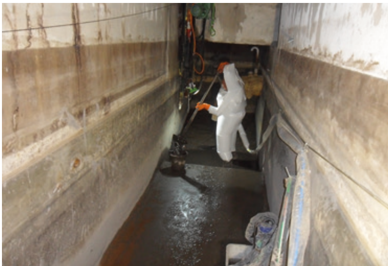
Abb. 6: Ein Rückbauer fördert kontaminierten Schlamm im Rückhaltebecken.
