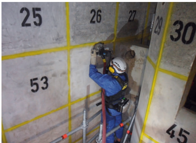
Abb. 7: Ein Rückbauer beim Erheben von Schleifproben an der Beckenwand
