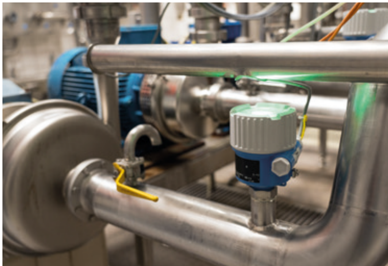
Abb. 7: Schwinggabel-Grenzstandsmessung in Rohrleitung
