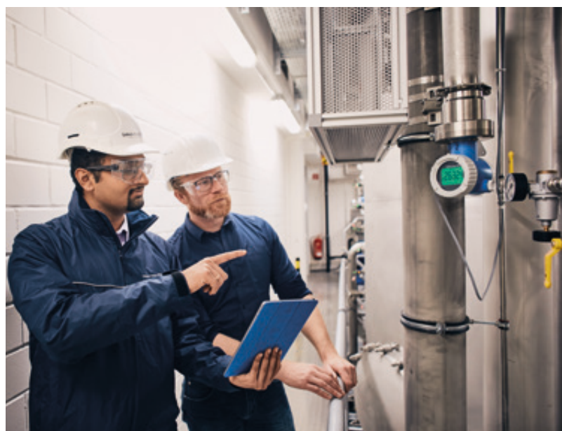
Abb. 3: Sichere Bedienung des Gammapiлот FMG50 außerhalb des Strahlengangs
