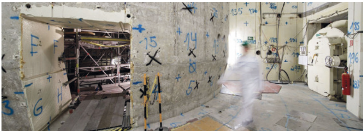
Abb. 4: Für die Freigabemessungen vorbereitete Betonstruktur in einer kerntechnischen Anlage
