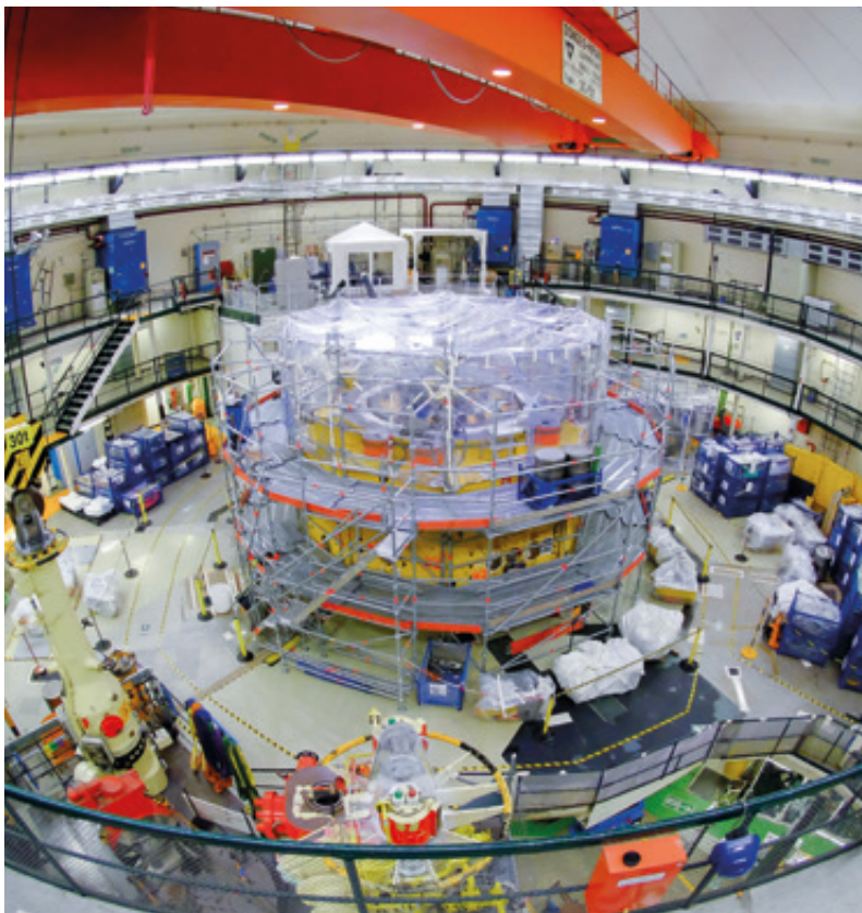
Abb. 1: Darstellung eines im Rückbau befindlichen Forschungsreaktors: Gut erkennbar ist die Bereitstellung von radioaktiven Reststoffen in Gitterboxen zur weiteren Bearbeitung.
