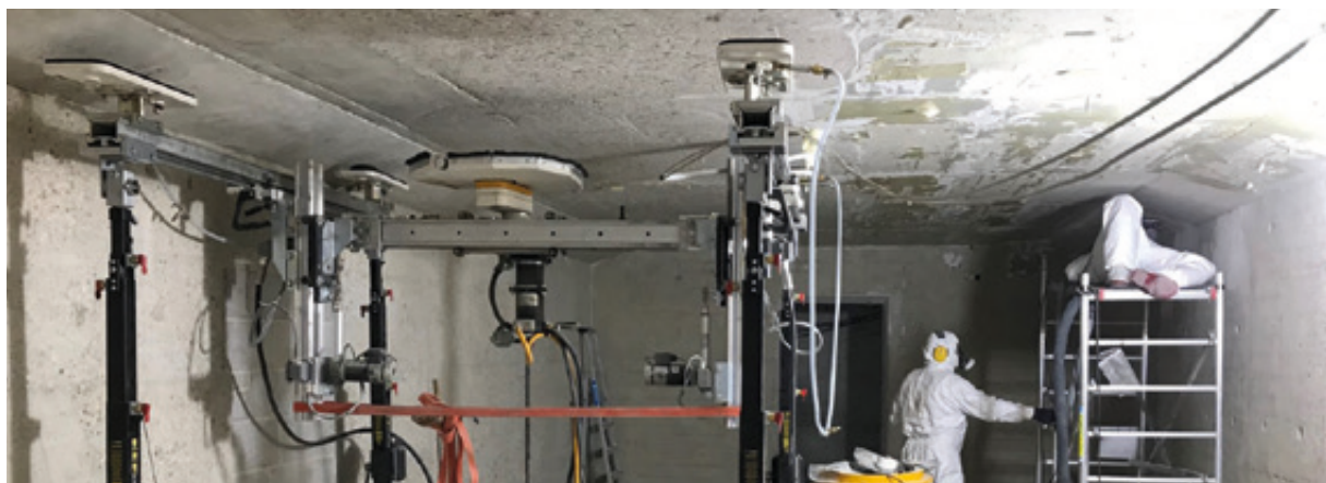
Abb. 2: Typische Situation im Rückbau: Abtragen von Oberflächen mittels Schleifen
