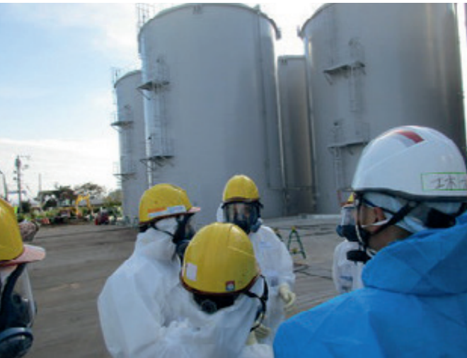
9 Lagerbehälter für Tritium-haltige Abwässer in Fukushima-Daiichi; Foto: TEPCO
