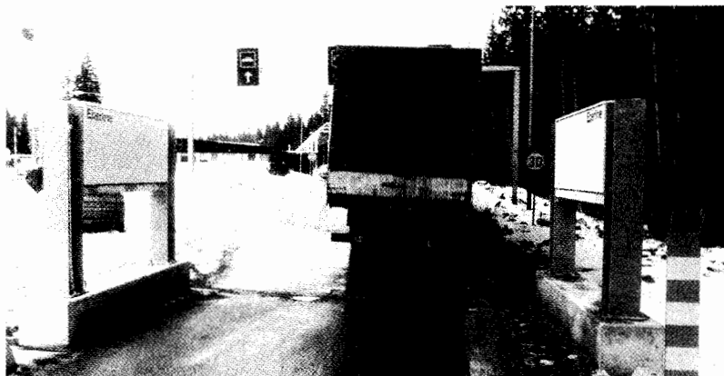
Vollautomatische Eberline-Überwachungssysteme an der finnisch-russischen Grenze. Zwei hochempfindliche Radioaktivitäts-Detektoren, rechts und links neben der Straße, kontrollieren alle durchfahrenden Fahrzeuge.
