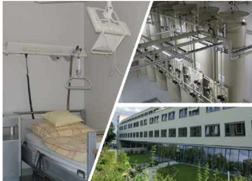
Abb. 2: Strahlenunfallstation Universitätsklinik Würzburg mit Abwasseranlage. (Bild: Universitätsklinikum Würzburg)
