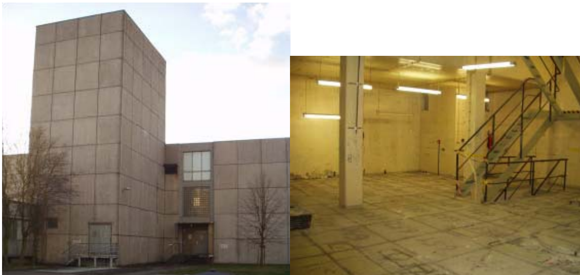
Abbildung 2: Gebäude 916, \text{D}_2\text{O} -Turm auf dem Gelände des Forschungszentrums Karlsruhe. Es ist die Außenansicht sowie die Innenansicht zum Zeitpunkt der Freigabe zu sehen.
