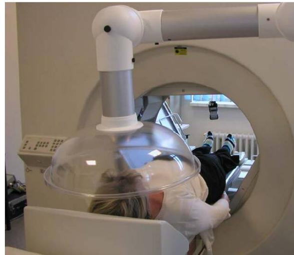
**Abb. 2.2-1:** Beispiel für die Anwendung einer Absaugglocke [PET 06] (typische Saugleistung 300 m<sup>3</sup>/h während und nach Ventilation über Patientenkopf positioniert).
