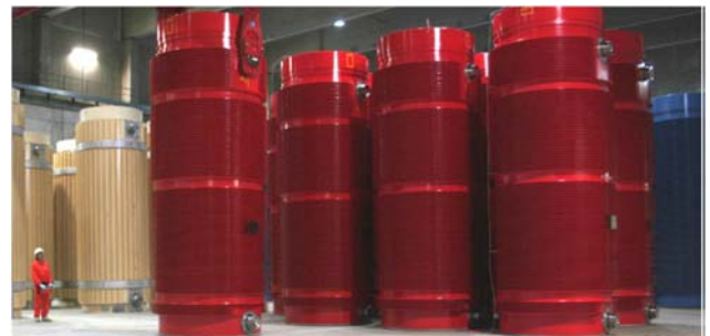
Behälter mit hochradioaktiven Abfällen im Zwischenlager Gorleben (Quelle: GNS)
